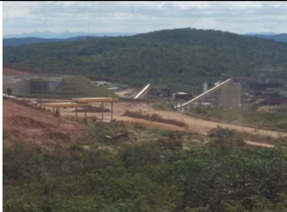
Foto 1. Vista Planta Hidrometalúrgia
