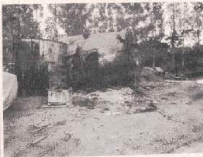
Foto 11: Tanques da antiga central de BPF
