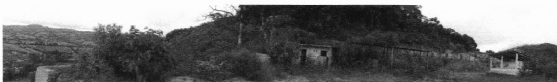
Figura 10: Panorâmica da recuperação da área destinada as unidades de apoio.
