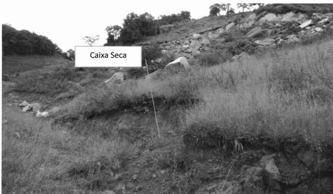
Figura 6: Recuperação das vias de acesso através do surgimento de gramíneas demonstrando que não há tráfego de veículos no local. Também é possível verificar a presença de caixa seca para evitar o carreamento de sedimentos.
