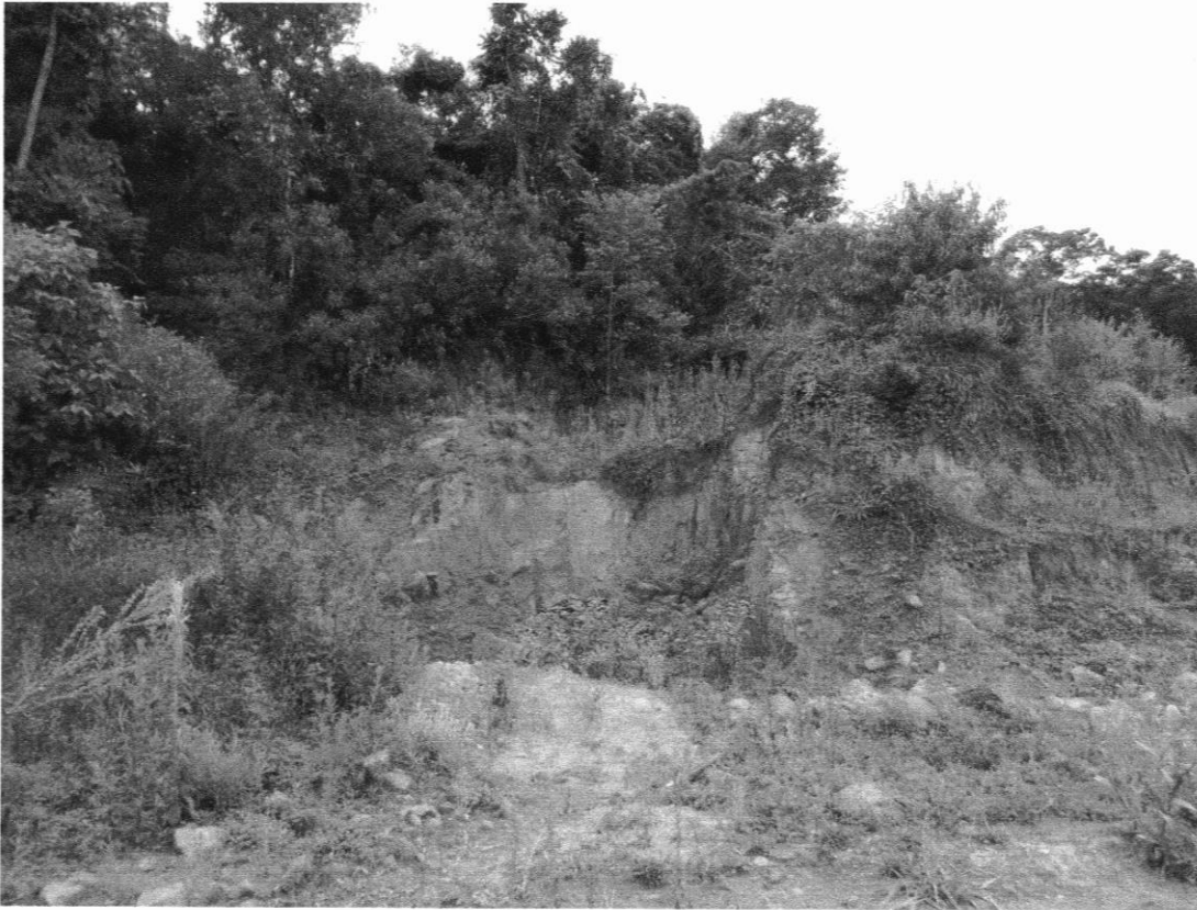
Figura 12: Caixa seca instalada no interior da lavra para evitar carreamento de sedimentos.
