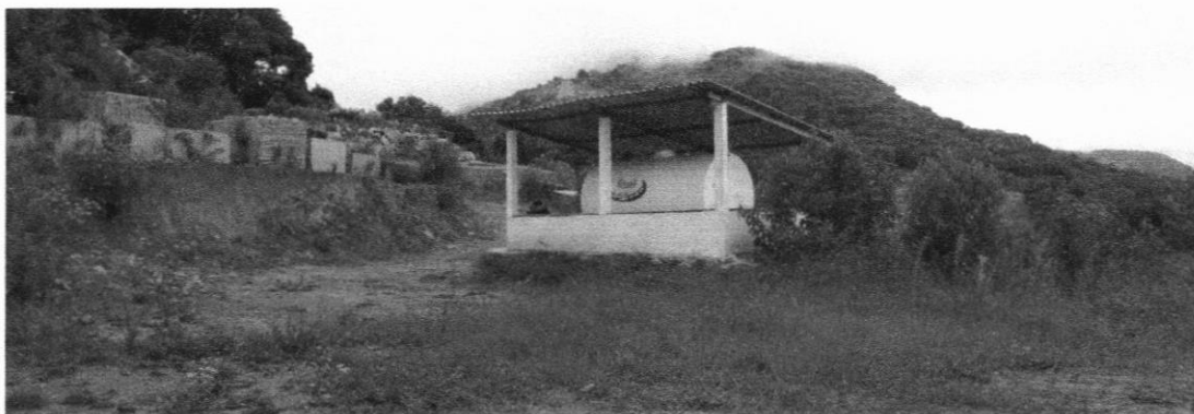
Figura 9: Recuperação Natural na área das unidades de apoio.
