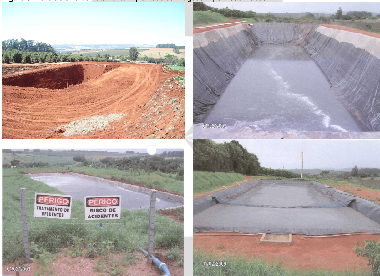
Figura 3. Novo sistema de tratamento implantado com lagoas impermeabilizadas.
