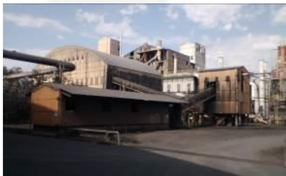
Foto 1 – Vista parcial do empreendimento
