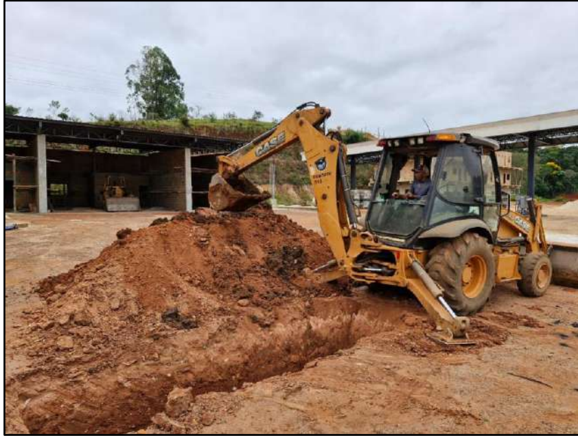
Figura 29 - Trincheira aberta com uso da retroescavadeira.
