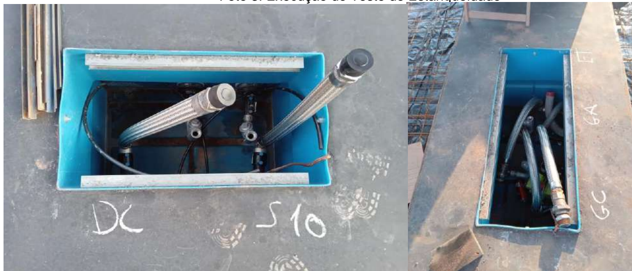
Foto 4: Local de instalação das bombas
