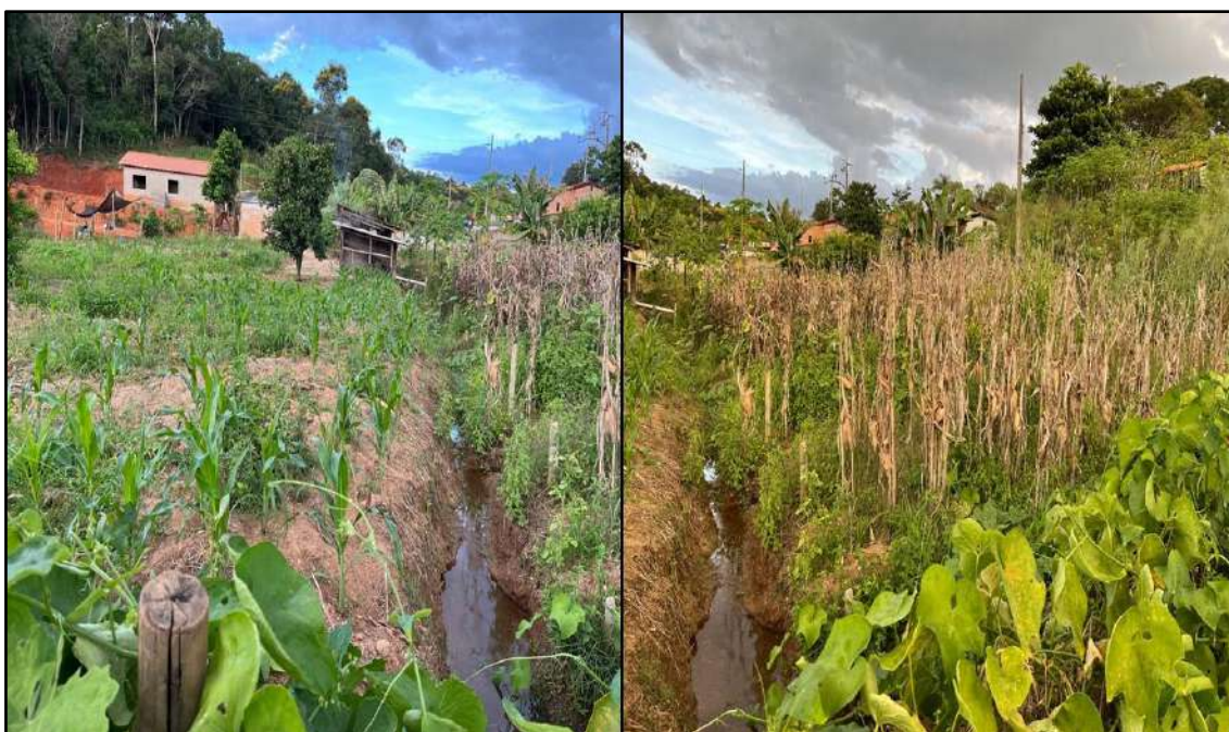
Figura 20 - Canal manual aberto por morador local para direcionamento de águas pluviais. Fonte: Arquivo profissional.
