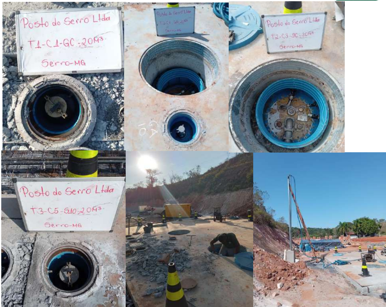
Foto 3: Execução do Teste de Estanqueidade
