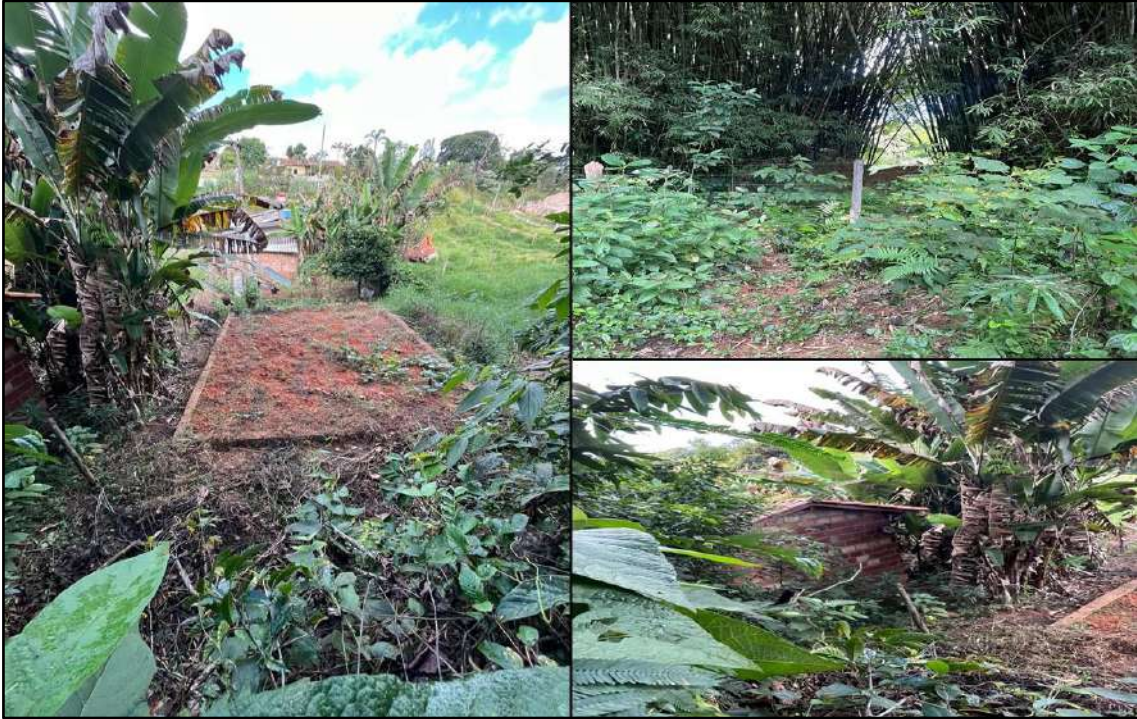
Figura 18 - Casa a jusante da barragem localizada na comunidade. Fonte: Arquivo Profissional.
