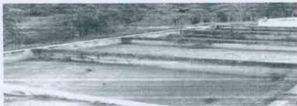
Figura 16 - Leitos de secagem de lodo
