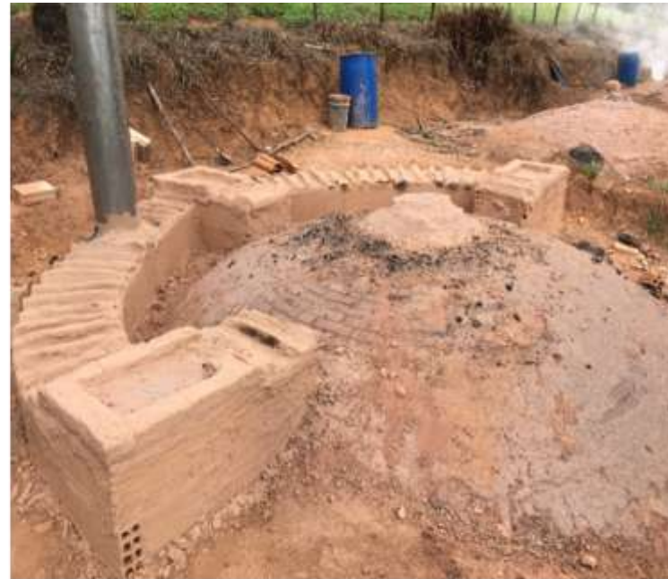
Condição do Forno após Adequação para Chaminé Única
