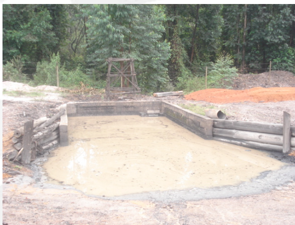
Foto 08. Bacia de contenção dos finos oriundo da atividade de carvoaria.
