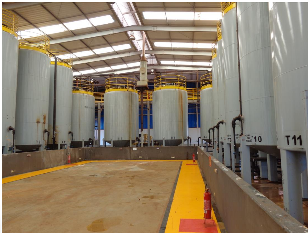
Foto 05: Tanques cobertos dotados de bacias de contenção
