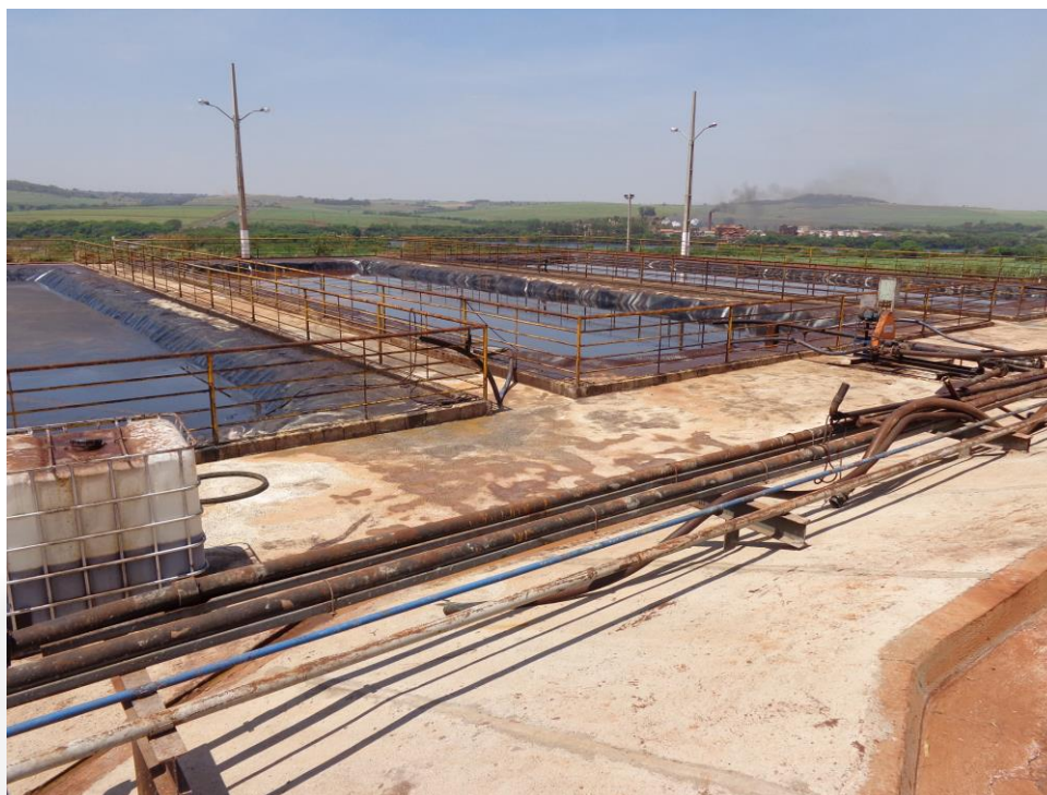
Figura 04: Tanques de armazenagem de efluentes
