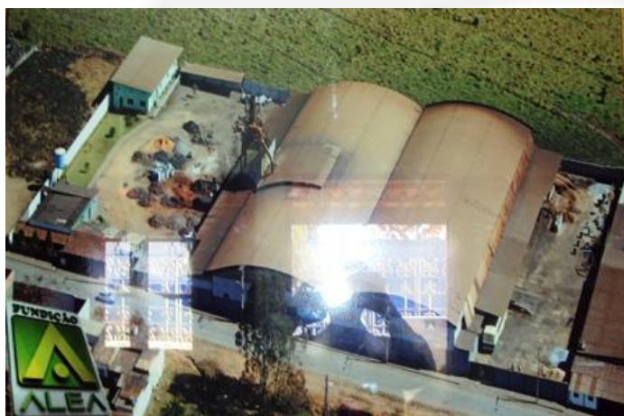
Foto 01. Vista aérea do empreendimento
