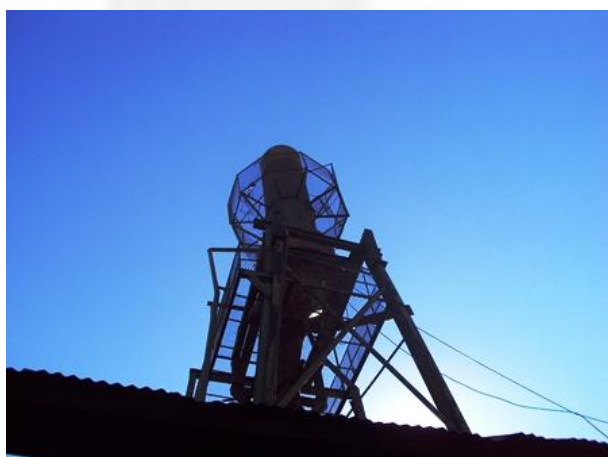
Foto 09. Chaminé do forno
