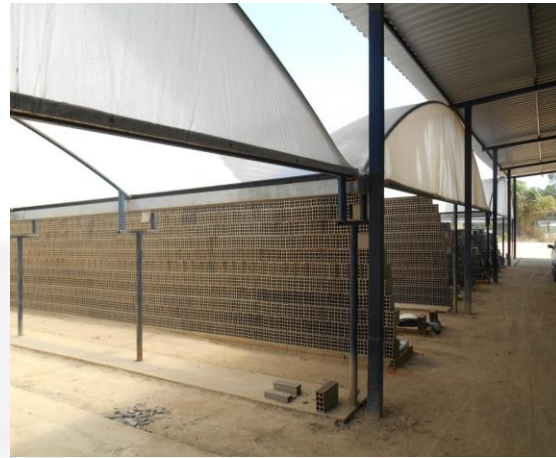
Foto 6: Estufas de secagem dos tijolos.
