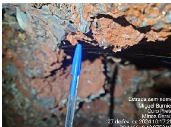
Foto 24 – Gotejamento no teto.
