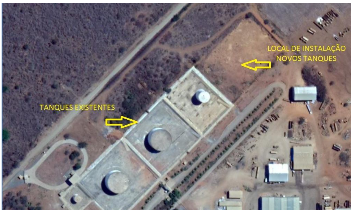
Figura 02: Local de instalação dos novos tanques
