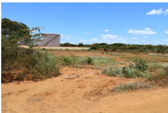
Foto 03. Vista do local de instalação da base de armazenamento.
