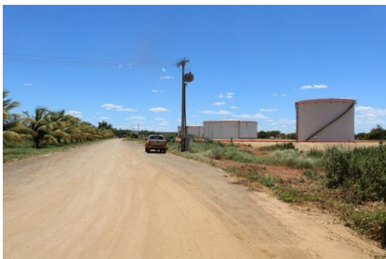
Foto 05. Tanques da base de armazenamento existente.
