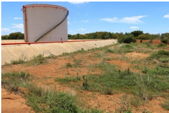
Foto 01. Local de implantação dos novos tanques, ao lado dos tanques já existentes.
