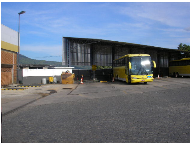
Foto 01: Vista da pista de abastecimento/ Área de descarga de efluentes sanitários ao fundo; e caixa SAO ao canto esquerdo e logo à frente setor de lavagem de veículo desativo.
