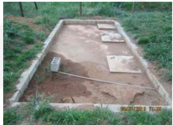
Foto 02: Fossa 2 – Novo Sistema Fossa/Filtro
