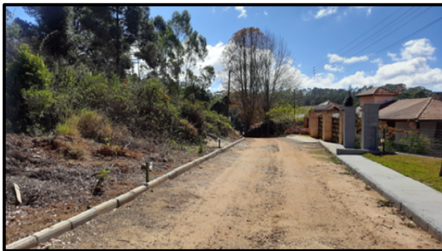
FIGURA 12: Imagem da propriedade vizinha aos Lotes nº. 21 e 35 da quadra C, no Loteamento Villas de Monte Verde III, Distrito de Monte Verde, Camanducaia/MG.
