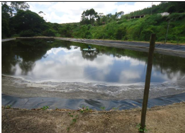
Foto 05. Lagoa para tratamento de efluentes líquidos industriais.
