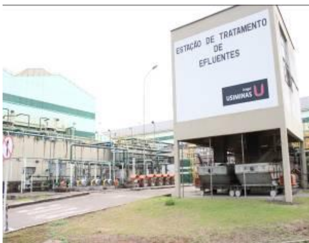
Foto 01: Estação de tratamento de efluente industrial da Unigal.
