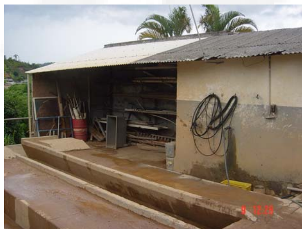
Foto 04. Lavador de veículos.
