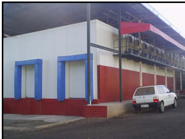
Foto 02. Entrada do matadouro Rio Doce
