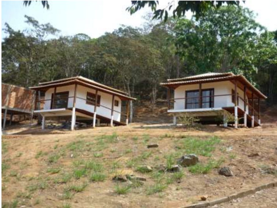
Figura 42: Chalés em fase final de acabamento
