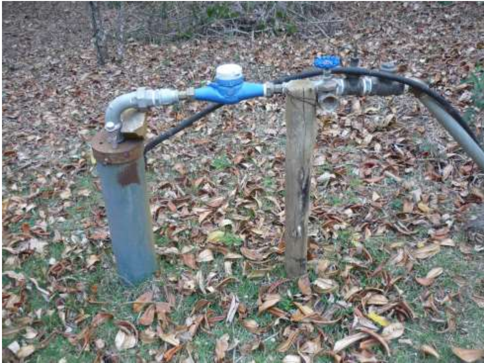
Figura 46: Poço tubular profundo instalado e outorgado
