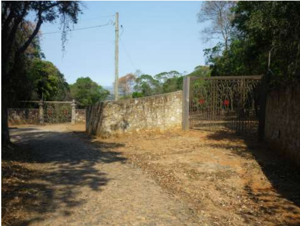
Figura 40: Portaria de entrada do complexo
