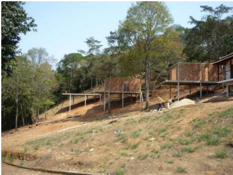
Figura 43: Chalés em construção
