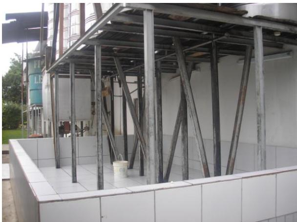
**Foto 01.** Bacia de contenção dos tanques de óleo.
