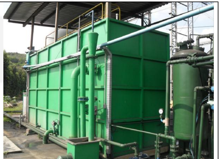
Foto 4. ETA – Estação de Tratamento de Água.
