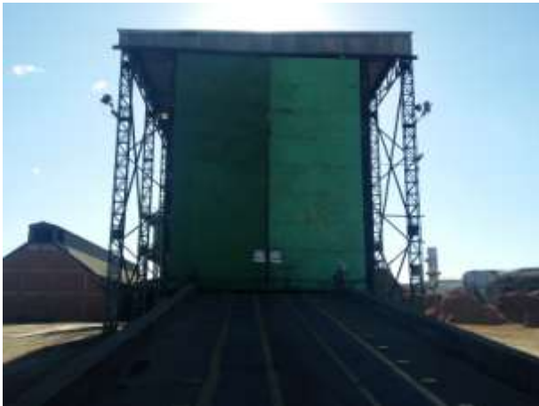
Foto 05. Sistema de Descarga de Carvão
