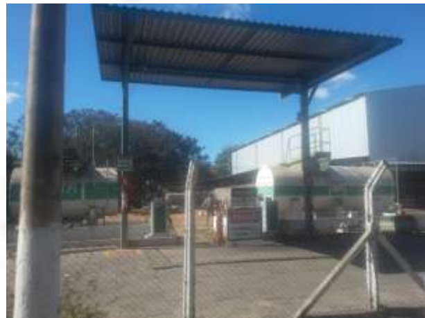
Foto 02. Posto de Combustível Licenciado
