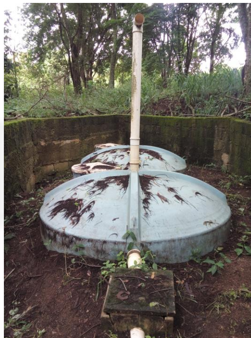
Imagem 2: tratamento de efluentes sanitários
