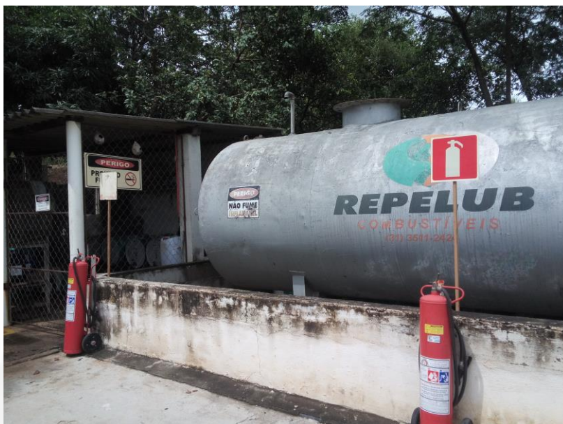
Imagem 4: Tanque de combustível 14.000 litros.
