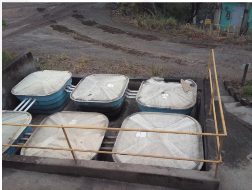
Imagem 3: Caixa separadoras de água e óleo (caixa SAO)
