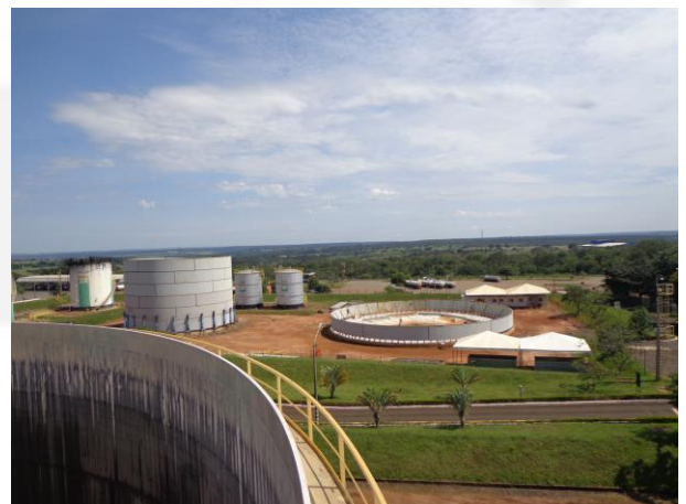
Foto 04. Vista da área de instalação dos tanques.
