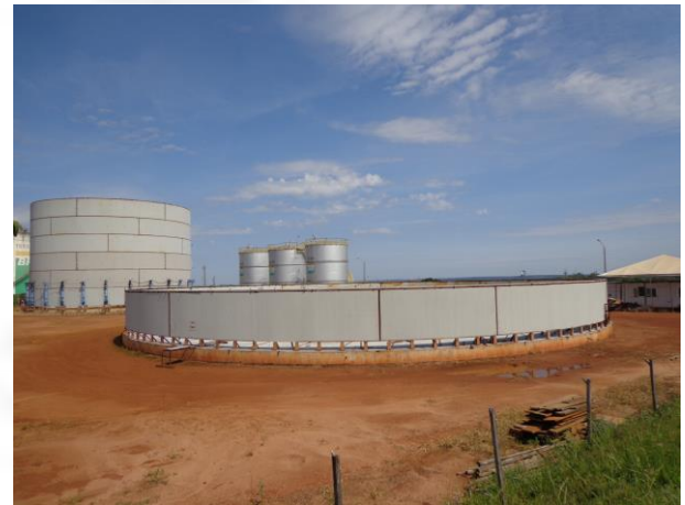
Foto 02. Tanques em instalação.
