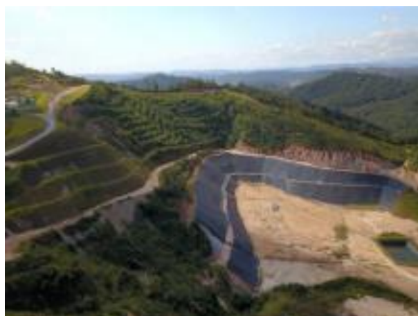
Foto 03. – Revegetação dos taludes no entorno do aterro
