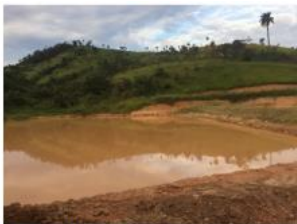
Foto 02. – Dique de contenção de finos
