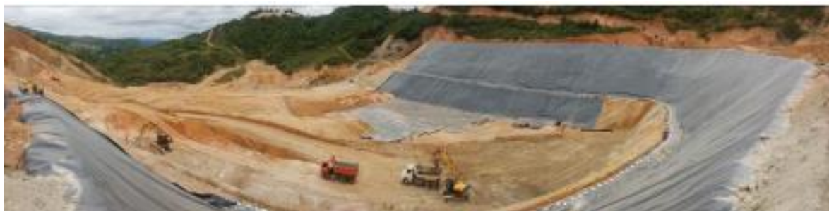
Foto 01. – Impermeabilização com manta PEAD
