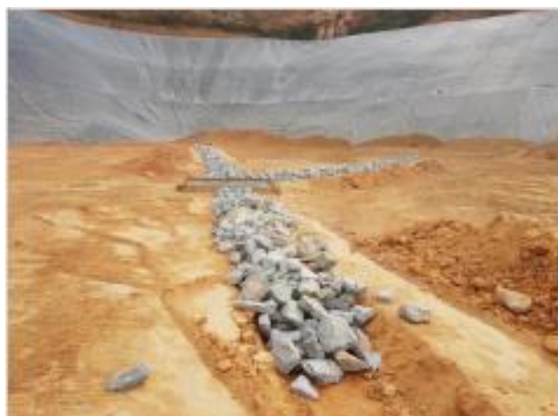
Foto 04. – Implantação da malha de drenos
