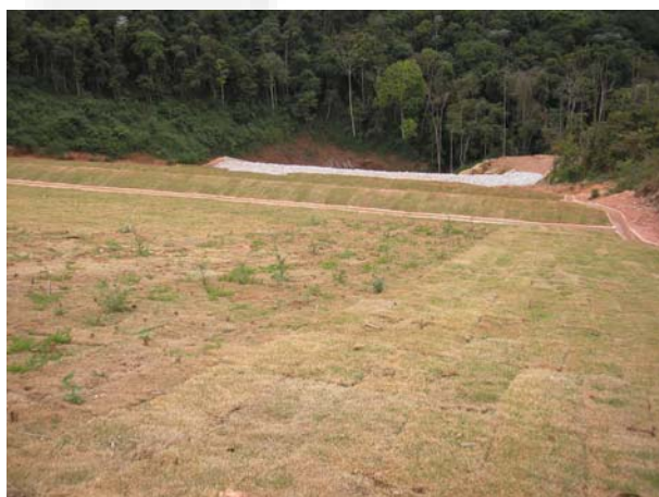
Foto 03. Pilha de Rejeito
