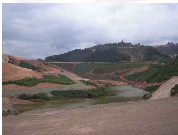
Foto 04. Pilha de Rejeito
