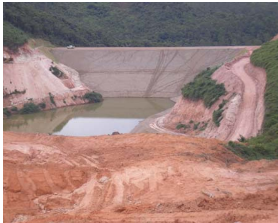
Foto 01. Pilha de Rejeito
