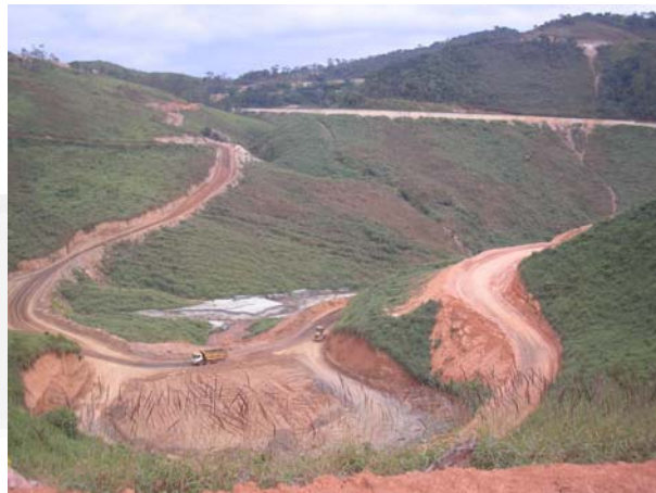
Foto 02. Pilha de Rejeito
