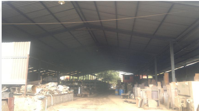
Foto 01: Vista do Galpão de disposição de sucatas
