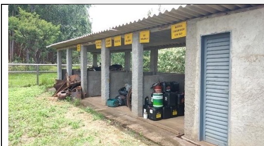
Foto 07: Central de armazenamento de resíduos.
