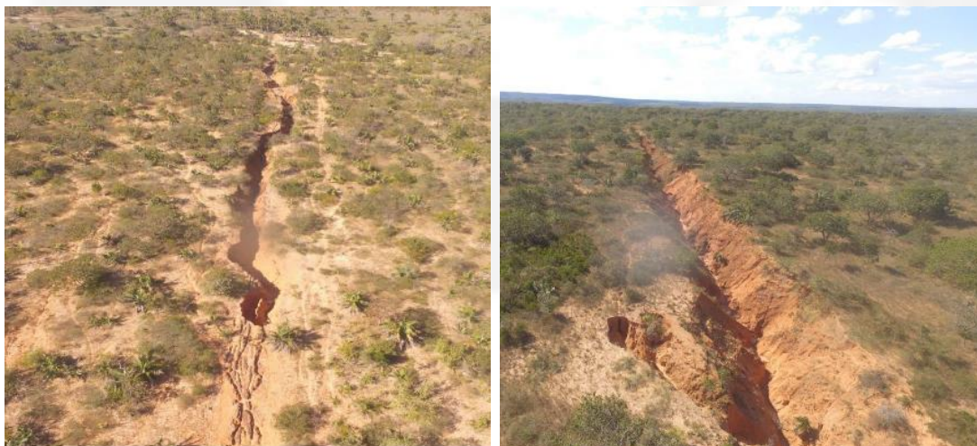
Foto 11: Áreas de processos erosivos.
