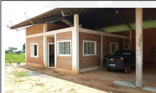
Foto 01: Escritório / Estacionamento na sede.
