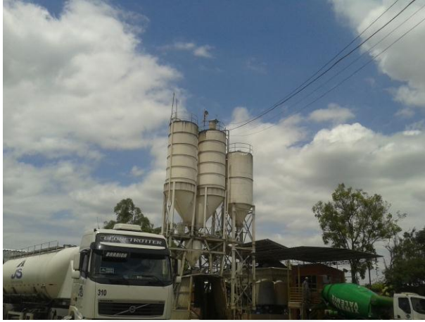
Foto 01. Silos para armazenagem de matéria-prima (cimento).
