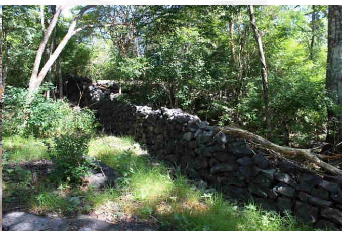
Foto 27: Muros de pedras.
