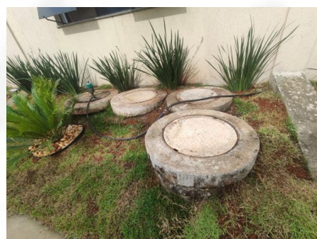
Foto 3: Caixa separadora de água e óleo que recebe os efluentes industriais, que correspondem ao efluente da lavagem de mãos no ambiente fabril e à purga do compressor
