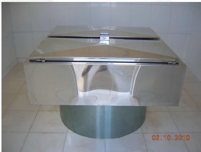
Figura 02. Caixa quadrada de coroamento do tubulão dentro da Casa de Proteção Fonte: EIA 2014
