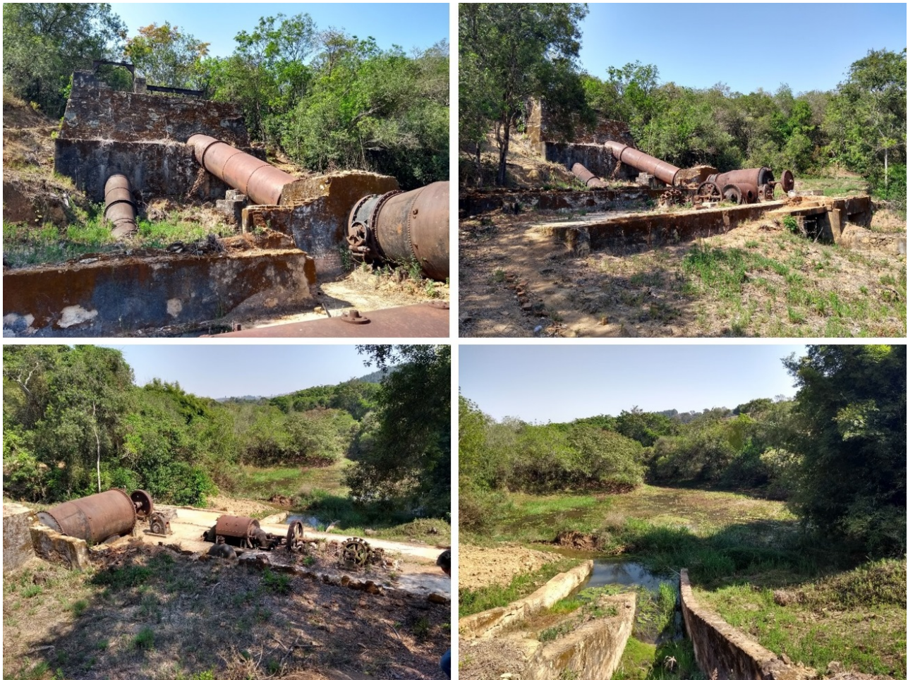
FIGURA 3 – A) Detalhe das estruturas da “casa de força” com sinais do intemperismo e canal de retorno preexistente no local.
