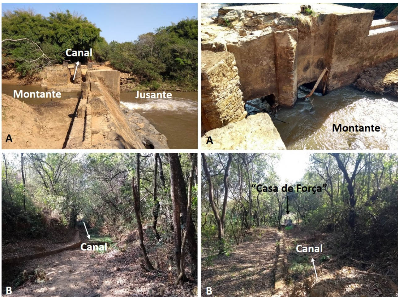
FIGURA 2 – A) Detalhe do barramento preexistente no local e B) Detalhe do canal de adução preexistente.
