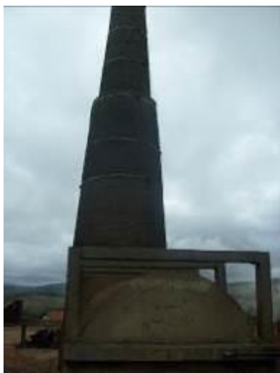
Foto 05: Queimador central de gases.
