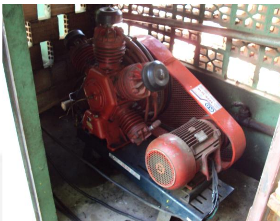
Foto 6: Compressor em área impermeabilizada.
