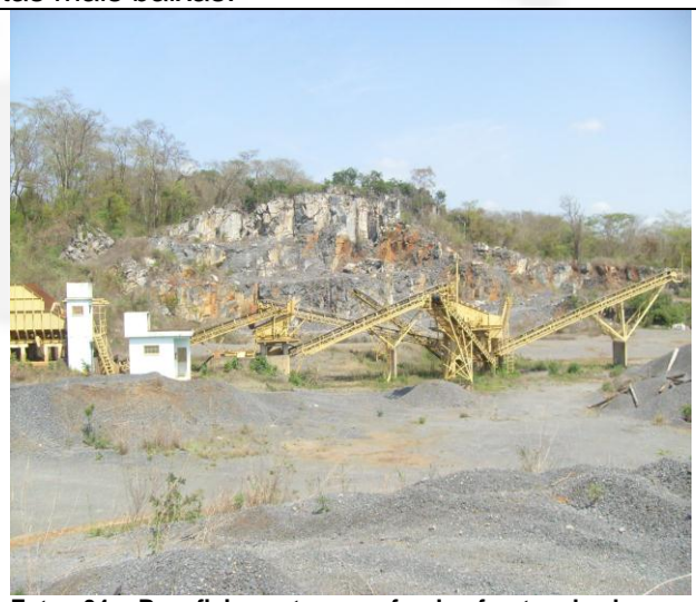
Foto 04: Beneficiamento, ao fundo frente de lavra paralisada.
