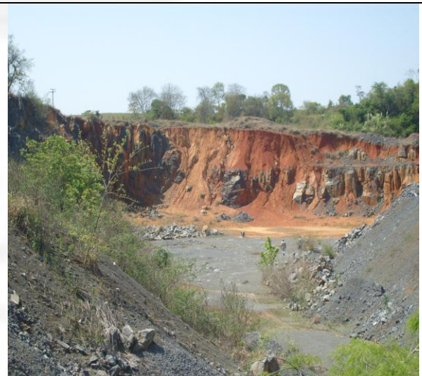
Foto 06: Vista da cava que será a implantada a pilha de estéril.
