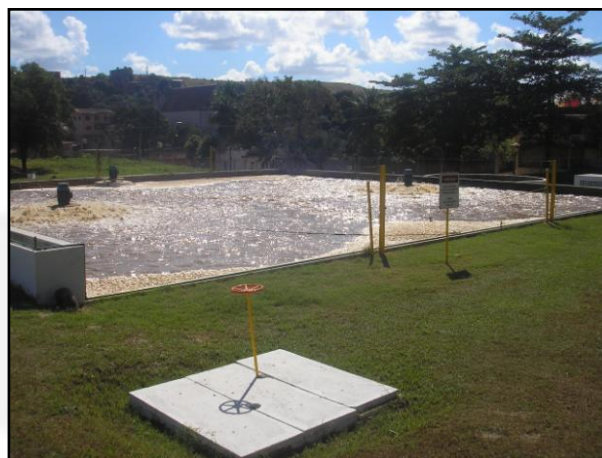
Foto 02. Tanque de aeração da Estação de Tratamento de Efluentes.
