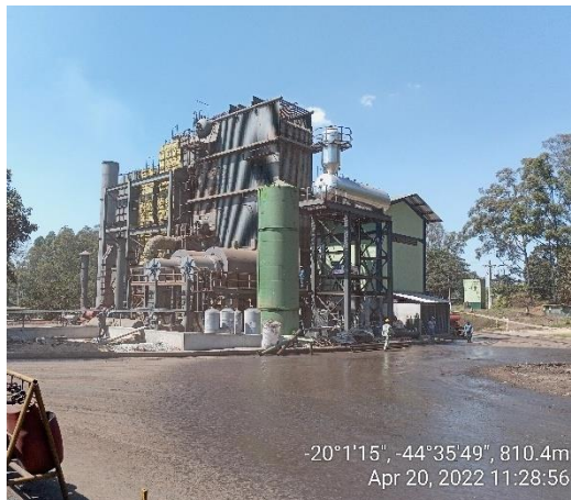
Foto 05. Termoelétrica em instalação.
