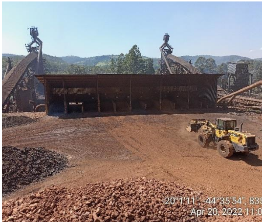
Foto 01. Pátio de minério, silo de secagem e altos fornos.
