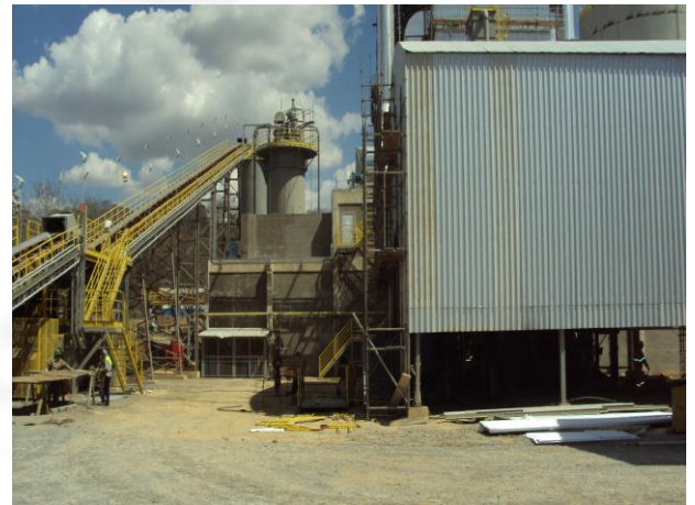
Foto 02. Correia transportadora (enclausurada)
