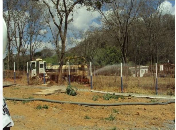
Foto 6. Aspersão das vias
