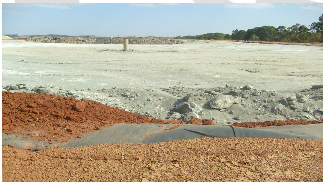
FIGURA 3: Célula de resíduo classe II em operação.
