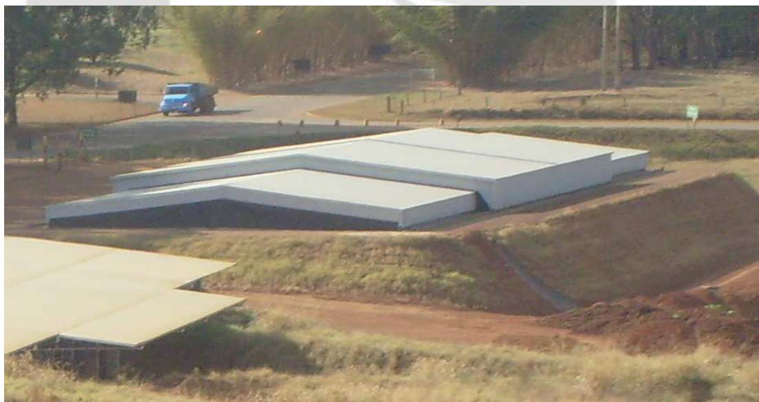
FIGURA 2: Célula de resíduo classe I em operação.
