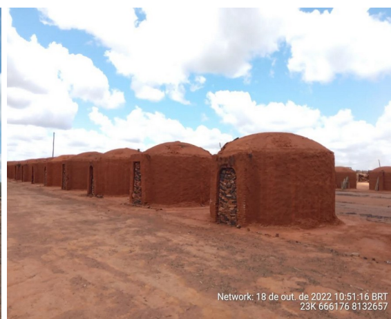
Imagem 04: Fornos de Alvenaria Circulares
