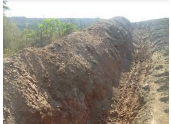
Trincheira para drenagem da lavra leste
