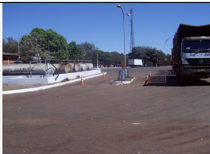
Figura 5 – Área de abastecimento de veículos sem canaletas de contenção e CSAO
