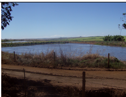
Figura 3- Bacias de sedimentação de águas residuárias (lavador de gases – lavagem da cana) sem impermeabilização
