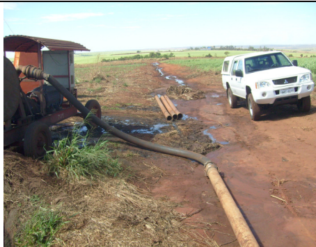
Figura 8 – Vazamento de vinhaça nas tubulações destinadas á fertirrigação
