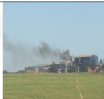
Figura 10 – Emissão de fumaça preta das chaminés das caldeiras
