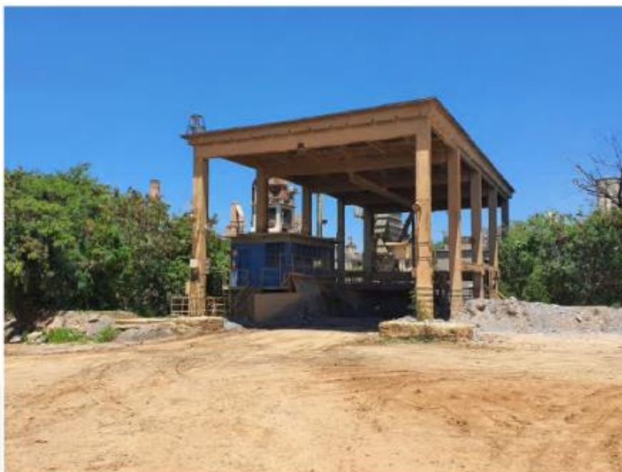
Figura 2.5: Área do britador primário. Fonte: EIA CCA.
