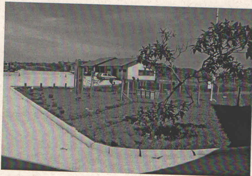
Figura 3: Piso do pátio do Centro Integrado, travado com meio fio nas laterais.
