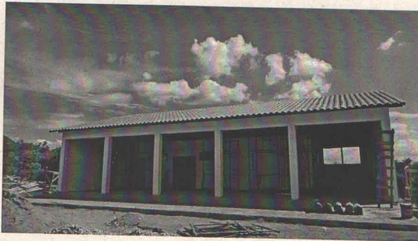
Figura 4: Vista do Centro de Manutenção/Garagem/Almoxarifado, em fase final de conclusão.
