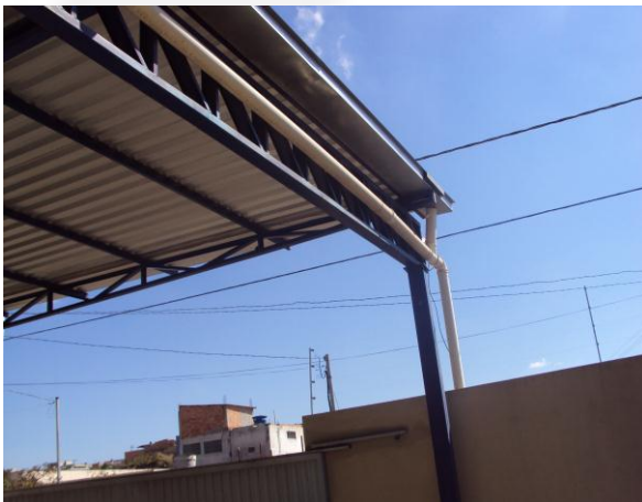
Foto 7: Sistema de drenagem de águas pluviais.
