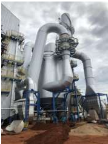
Foto 01. Lavador de gases da caldeira.
